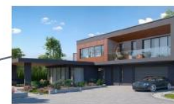
Villa Lavanda Construction started—till Q1.2018
