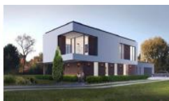
Construction Q1.2018 - Q1.2019
